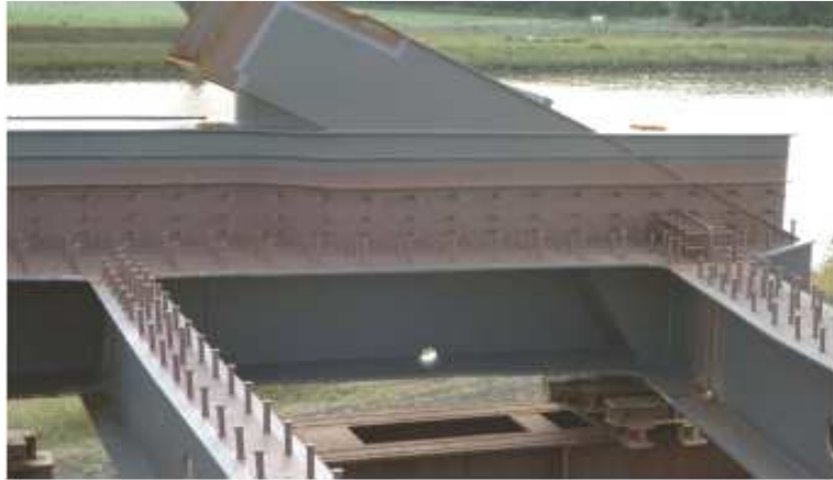
Kompozit köprünün bitiş noktası
