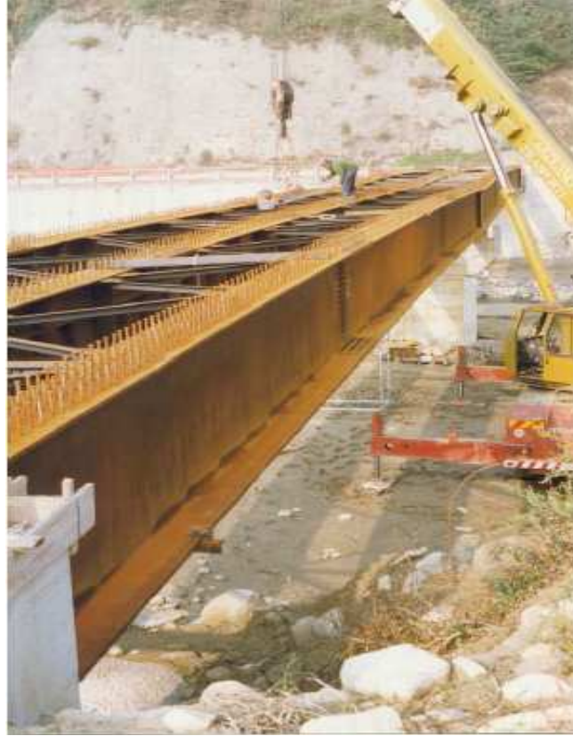
I-profiliden inşa edilen kompozit köprü montajı
