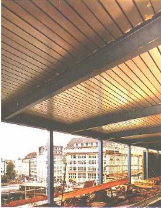
Yüksek yapılarda geniş aralıklı taşıyıcı kolonlar
